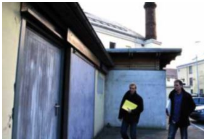
Det er lett å tenke seg at denne skyvedøra foran et stort panoramavindu kan utvides til en trippel rømningsvei rett ut fra hovedkonsertlokalet i Mølla. Brannrådgiver Pål Dahle (t.v.) blir vist rundt i bygget av eiendomssjef Sveinung Riska.
