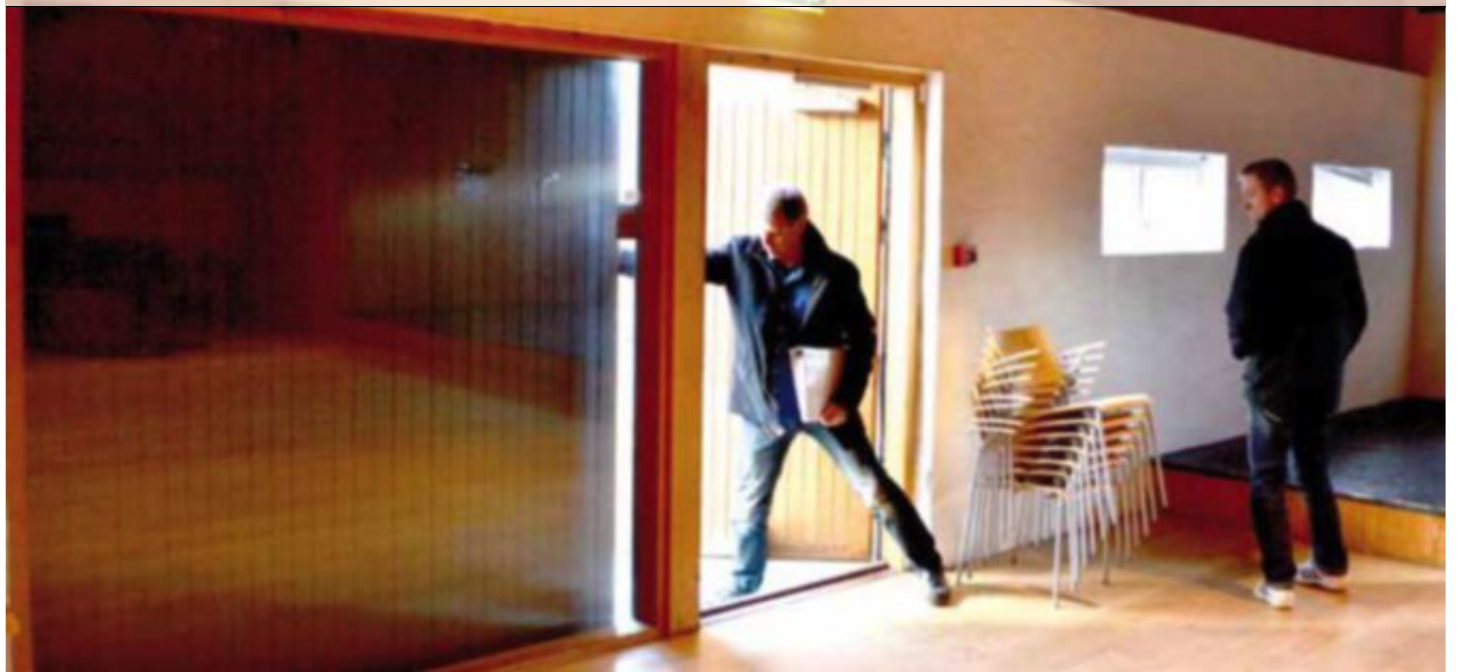
Times eiendomssjef Sveinung Riska åpner en av rømningsveiene for brannrådgiver Pål Dahle da det i går ble tatt en ny risikovurdering av Bryne mølle. Til venstre skjuler skyvedøren et stort vindu som ved enkle tiltak også kan gjøres om til fluktvei. ALLE FOTO: GEIR SVEEN
